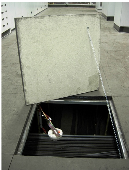
Abbildung 4: Montage der Kette
