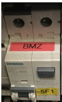
Abbildung 2: Sicherungsautomat FI/LS Kombischalter C16A Typ G
