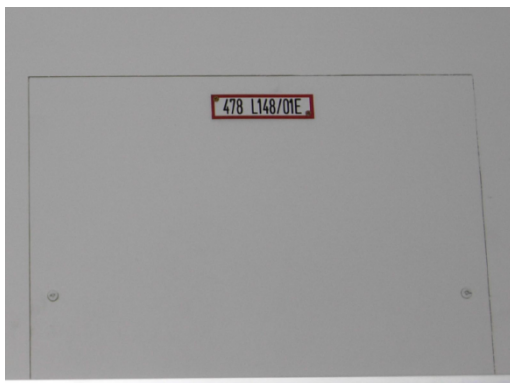
Abbildung 10: Kennzeichnung von Brandmeldern bei Installationsschächten
