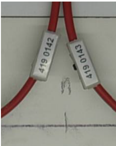
Abbildung 11: Kabelbeschriftungen
