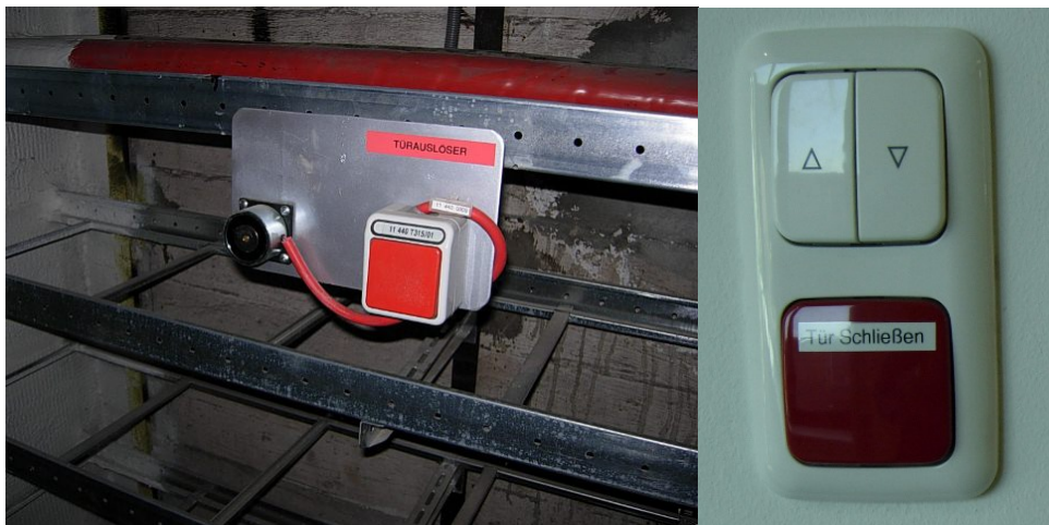
Abbildung 1: Auslösetaster für Haltemagnete AP und UP
