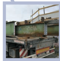
Ende der Nutzungsphase - Rückbau
